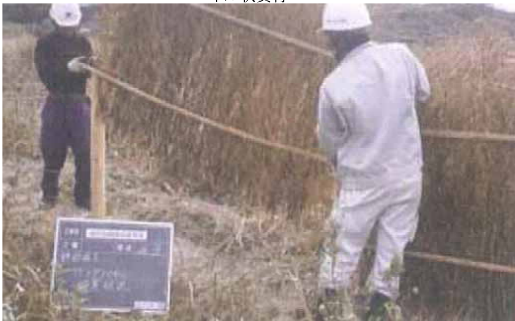
パネル状資材設置状況
