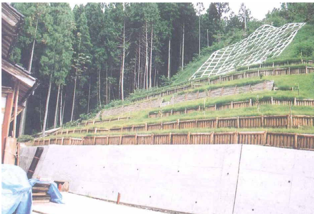
木柵工 平成 10 年度施工 / L=145.2m スギ間伐材 16.7 m 3 使用
