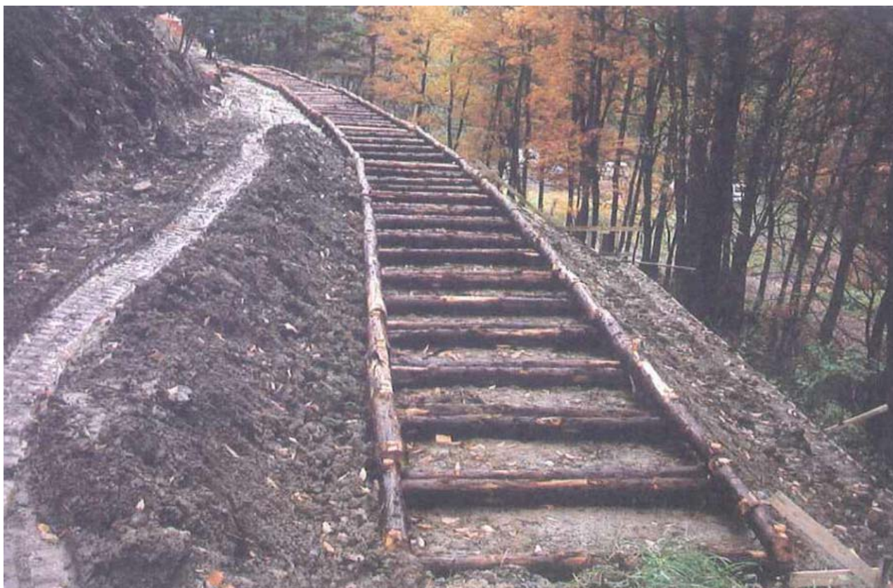
盛土工用 平成12年度施工／L=245m スギ間伐材 12 m 3 使用
