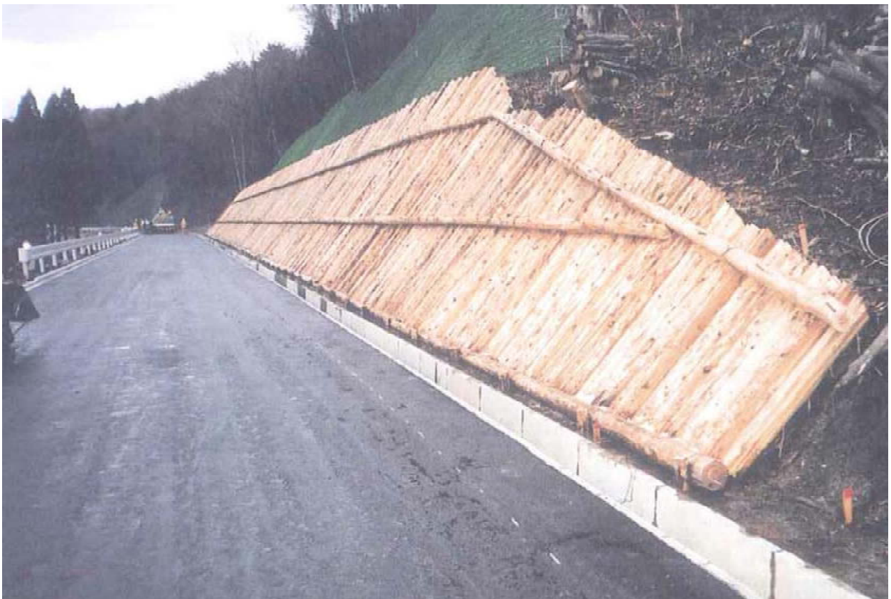
丸太法面保護工（切土面）L=72m スギ間伐材
