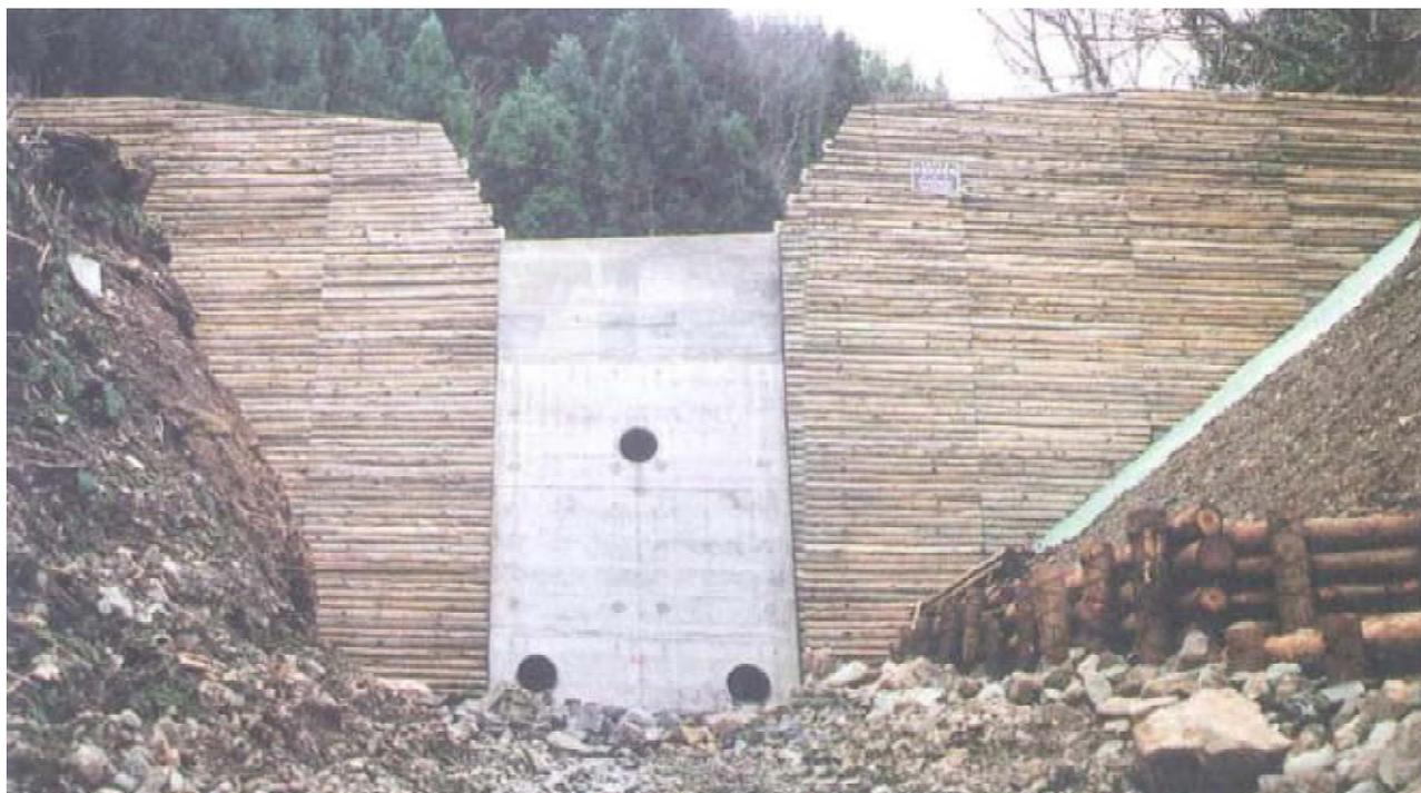
平成 10 年度施工 / S=88.0 m<sup>2</sup> スギ間伐材 8.0 m<sup>3</sup>
