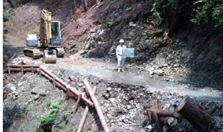
土質はれき混じり土、路肩は盛土で補強の為に木柵工を敷設した。盛土には排水性を高めるため岩砕、れきを使用。前後に勾配の変化点を設けているため路面水の影響は無い。尾根付近であり、小さな谷地形、常時湧水は無いので排水対策はしていない。被災原因は梅雨時期に山側からの雨水が集中したものの考えられる。
