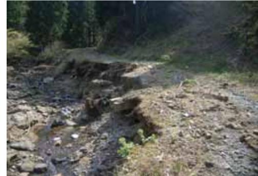
土質は礫混じり土、河川の増水による盛土路体の洗堀による崩壊。
