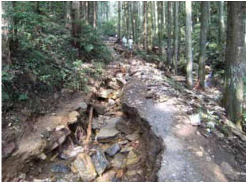
集中豪雨により上流のからの土砂崩壊により沢が埋まり路体に雨水が流れ込み路面を洗堀。路面に雨水が浸入しないようのっこの作設も有効
