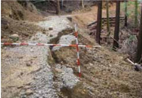
粘質土、地山勾配30°の為丸太組を施工。局所的大雨で路面水が集中し路肩部分が崩壊。こまめな分散排水が出来ていなかった。
