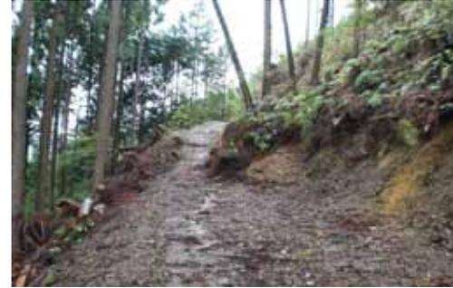
土質は赤土で砂利層含む、崩壊地ではない。盛土は表土ブロック積工、切土法面高は2m以内であったが切り土面に雨水浸透し崩壊。切土高を抑えても地質特性により崩壊を誘因する場合がある。施工地周辺において過去に開設した箇所の状況調査は有効
