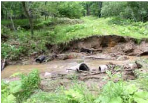
大雨による沢水の増加で埋設した暗渠が決壊した。
