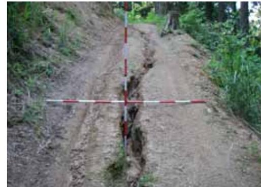
台風時に雨水が路面に進入し路面を洗堀。縦断勾配が急な場合、雨水分散の横断溝等のみで対応出来ない事もある。急勾配箇所にはコンクリート路面工を合わせ施工することも有効
