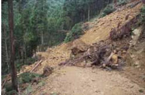
施工後の切土法面の高さが2.5mあり、梅雨期の長雨で法面が崩壊した。
