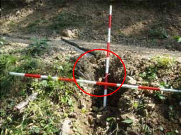
縦断勾配は7%程度、土質はれき質土、路面水対策のため路面水切横断工を敷設。路肩は地山(盛土ではない)
