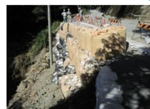
応急仮工事の事例（土のう積みにより通行確保）
