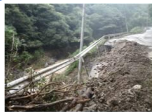
応急仮工事の事例（土のう積みにより通行確保）
