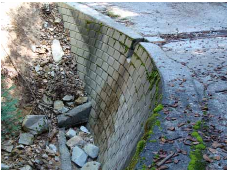
調査No10 吐口工
