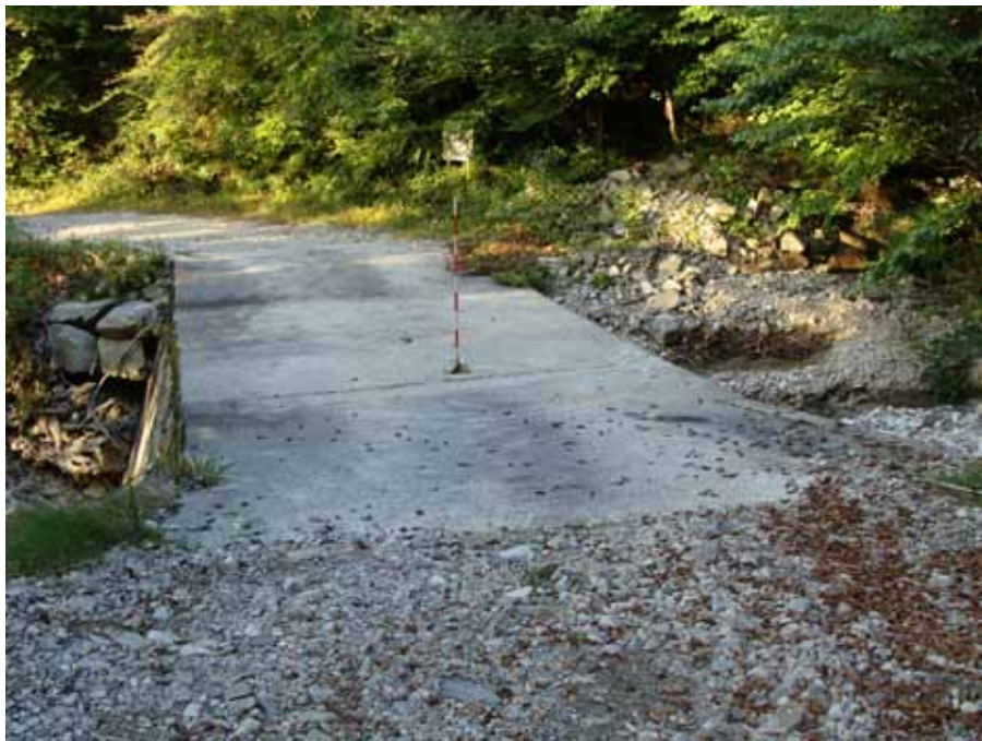
調査No14 暗渠付帯洗越工 排水施設安全率0.07 洗越安全率0.18 合算安全率0.25
