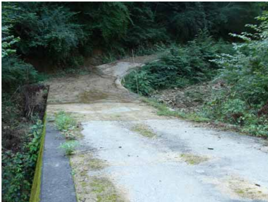
調査No16 暗渠付帯洗越工 排水施設安全率4.50 洗越安全率2.07 合算安全率6.57
