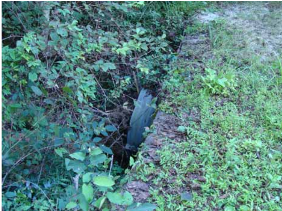
調査No12 呑口工
