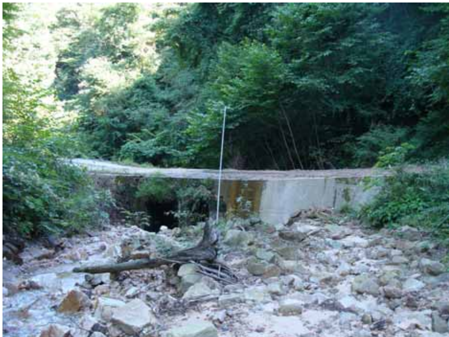
調査No16 呑口工
