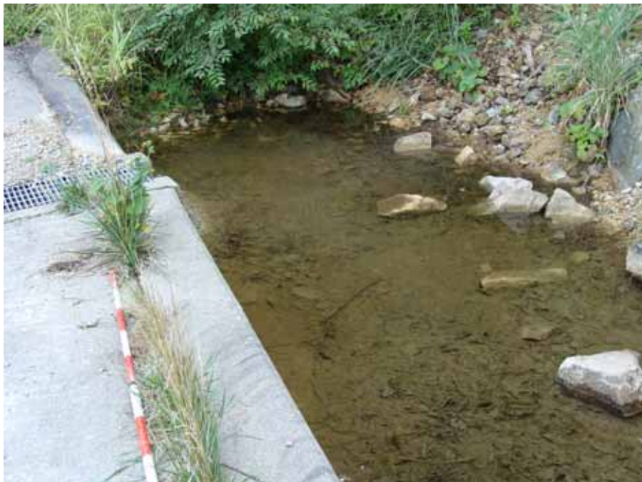
調査No9 呑口工
