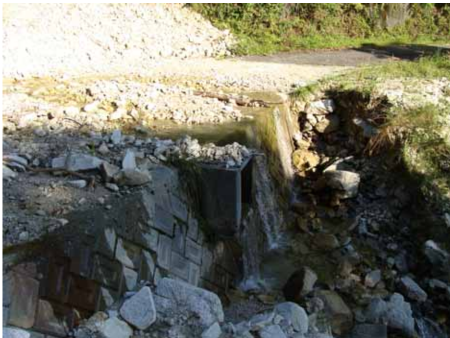
調査No13 吐口工
