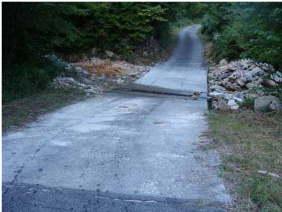
調査No14-1 横断溝付帯洗越工 排水施設安全率0.04 洗越安全率2.45 合算安全率2.49
