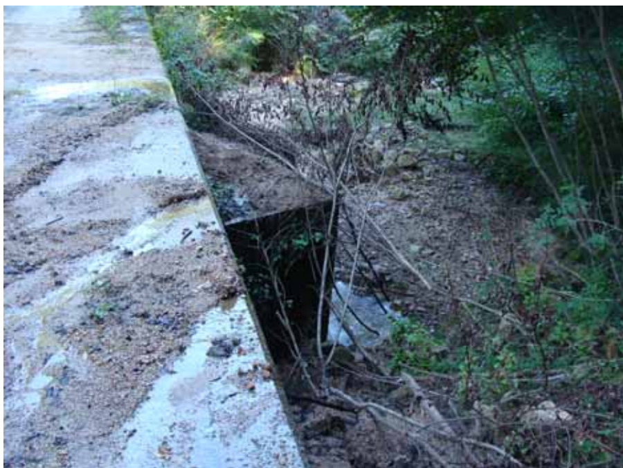
調査No16 吐口工
