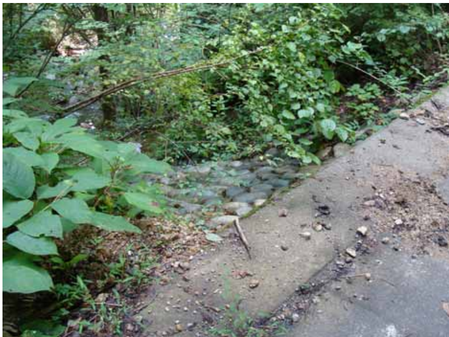
調査No8 水叩き部
