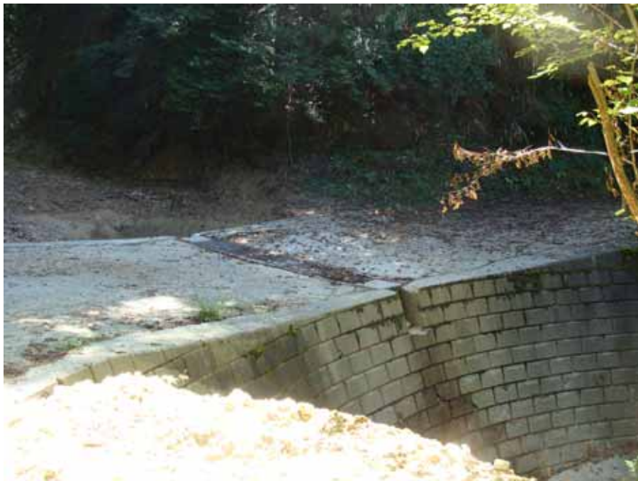
調査No10 横断溝付帯洗越工 排水施設安全率0.13 洗越安全率0.93 合算安全率1.06
