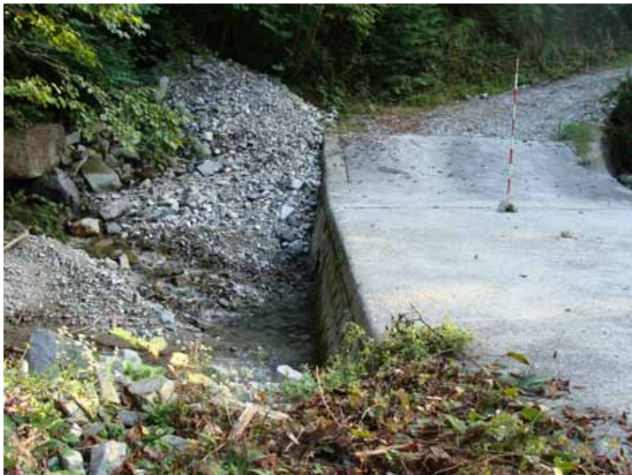
調査No14 呑口工
