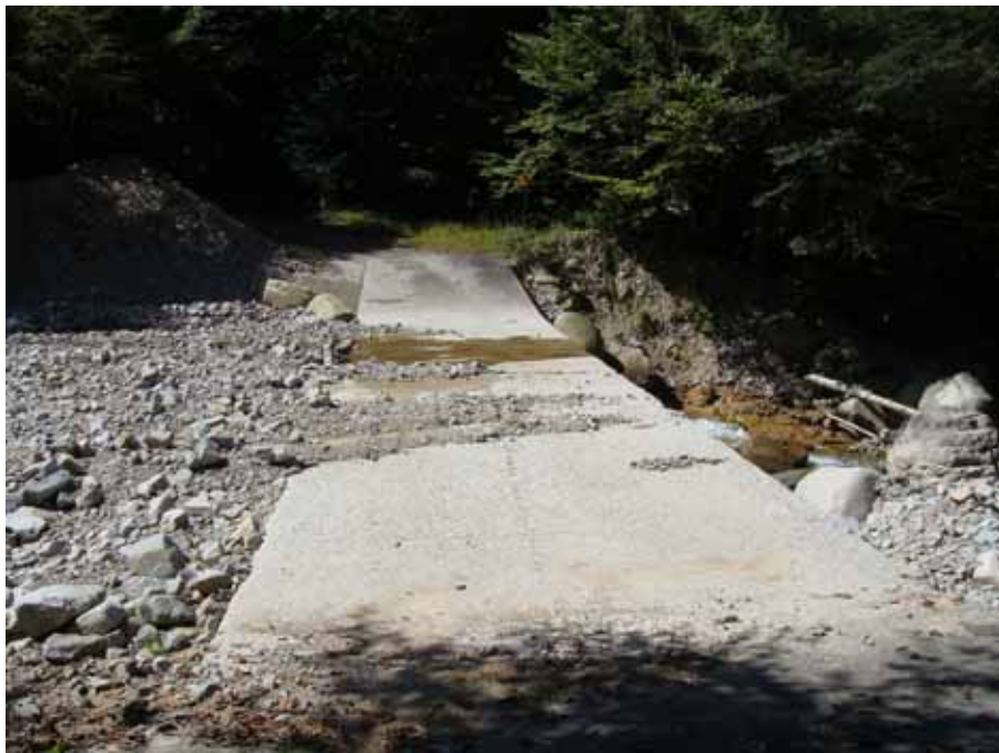
調査No11 床固工兼用洗越工 排水施設安全率0.35 洗越安全率0.38 合算安全率0.73
