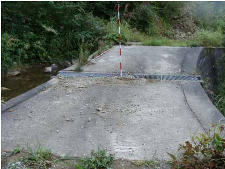
調査No9 横断溝付帯洗越工 排水施設安全率2.08 洗越安全率8.53 合算安全率10.61
