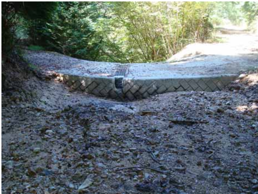
調査No10 呑口工
