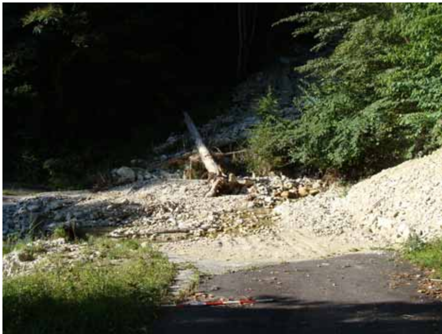
調査No13 横断溝付帯洗越工 排水施設安全率0.30 洗越安全率0.59 合算安全率0.89
