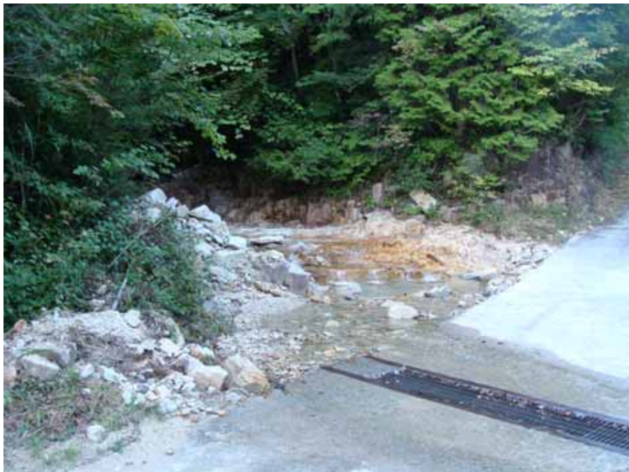
調査No14-1 呑口工
