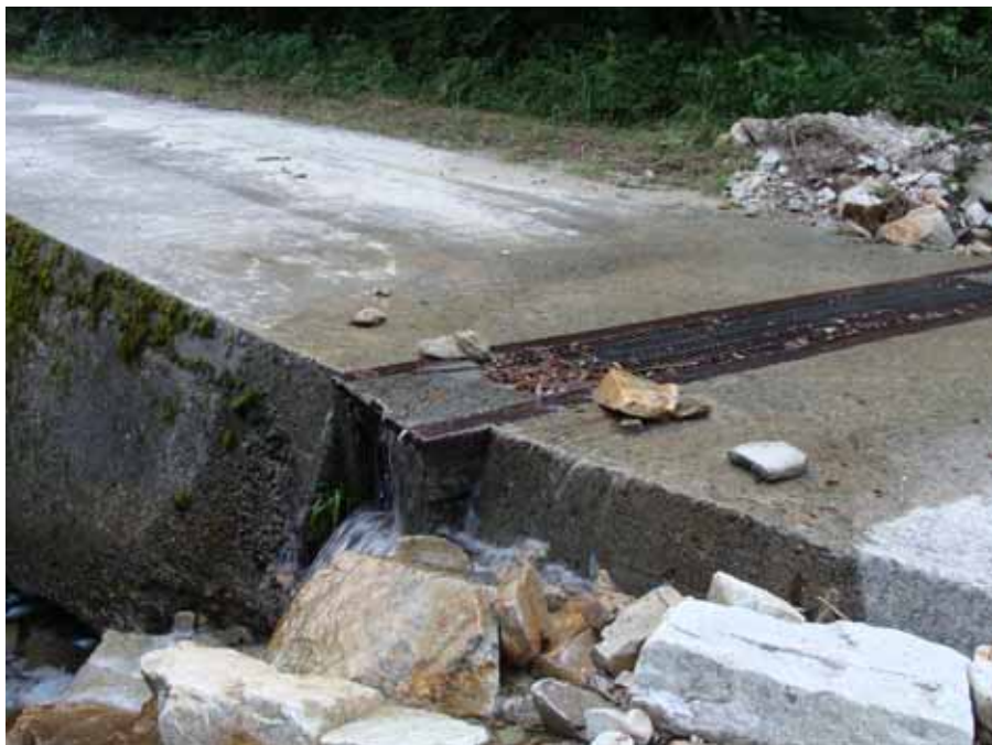
調査No14-1 吐口工
