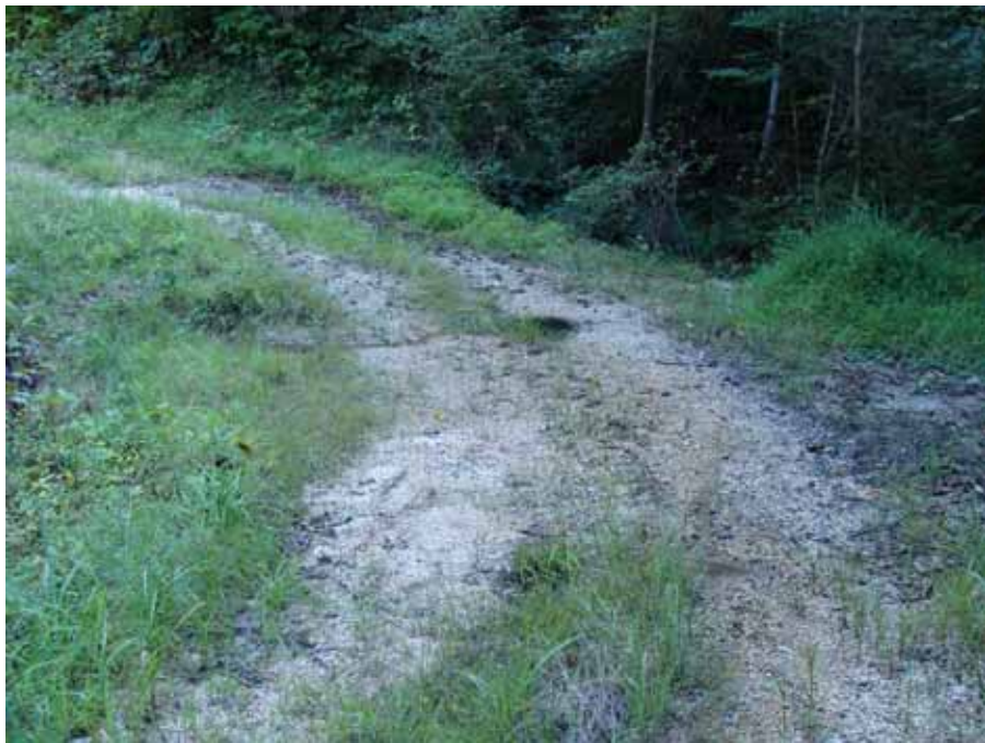
調査No18 暗渠付帯洗越工 排水施設安全率1.12 洗越安全率1.20 合算安全率2.32
