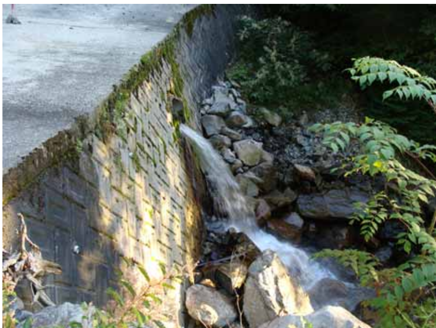
調査No14 吐口工
