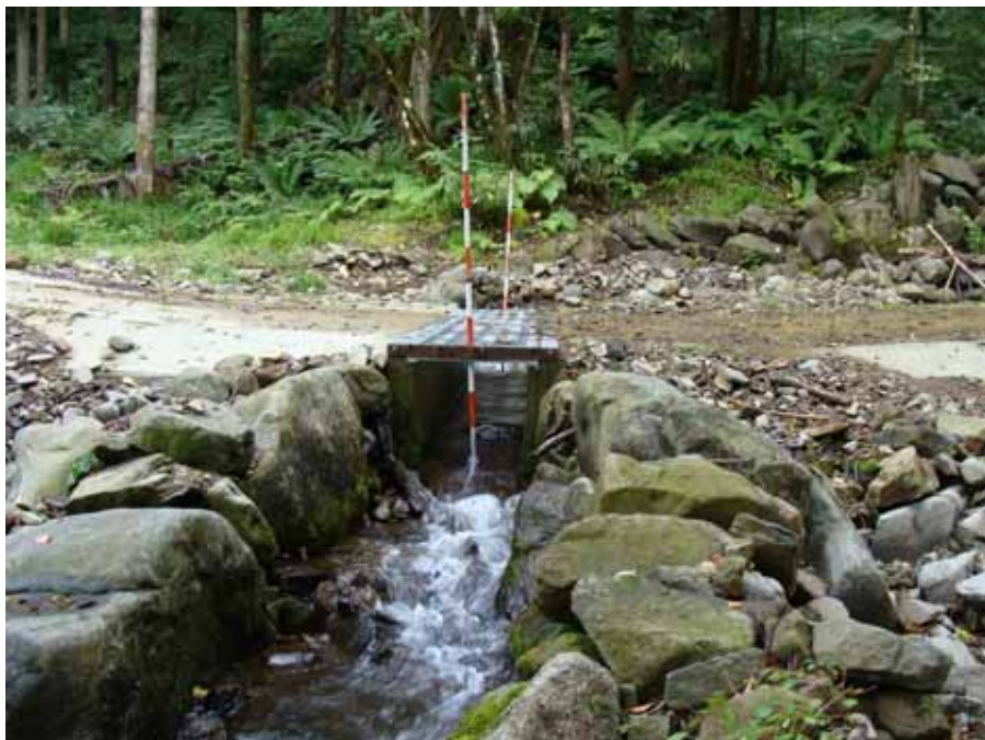
調査No21 吐口工
