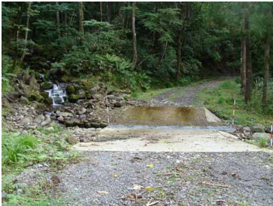
調査No21 横断溝付帯洗越工 排水施設安全率0.22 洗越安全率0.93 合算安全率1.15
