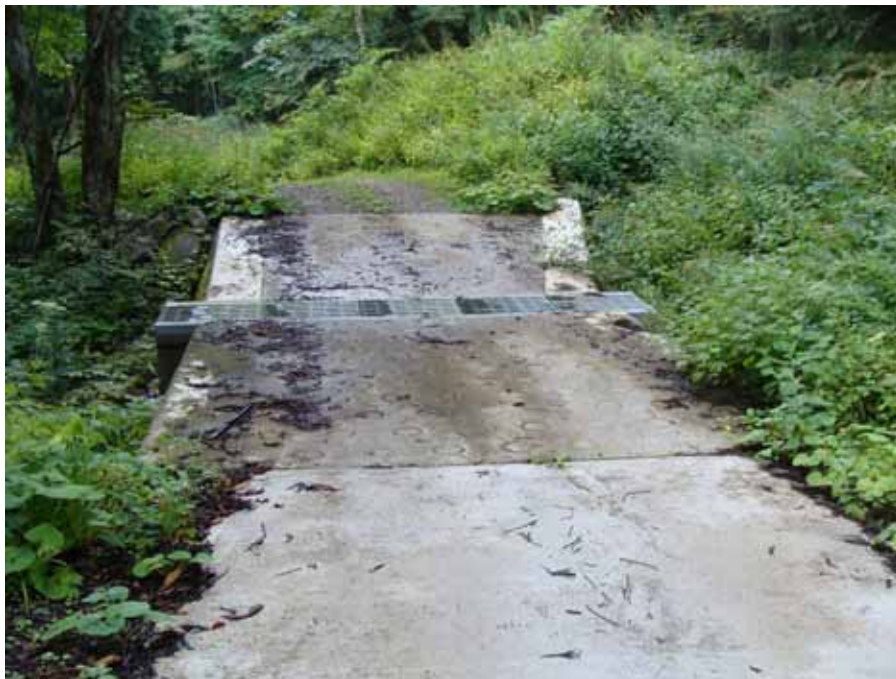
調査No3 横断溝付帯洗越工 排水施設安全率3.07 洗越安全率0.22 合算安全率3.29
