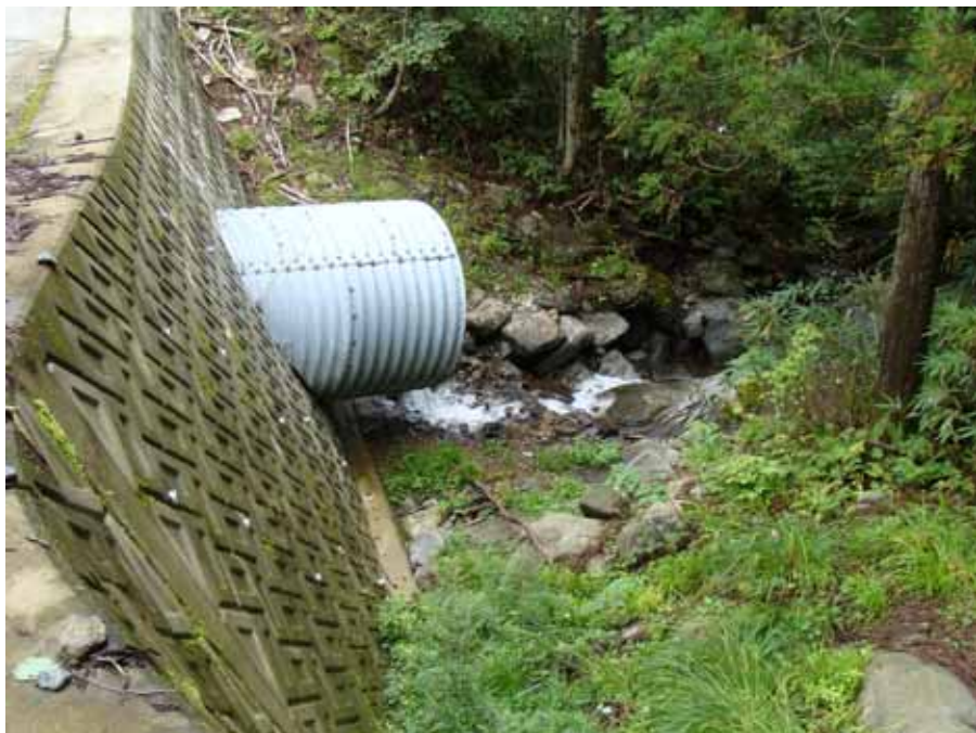
調査No20 吐口工
