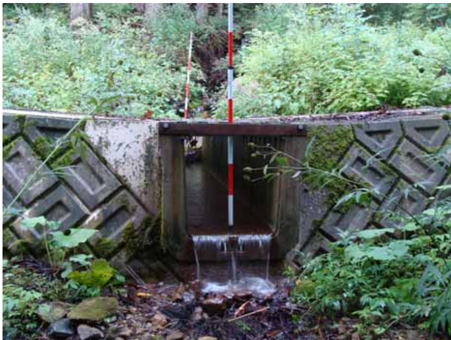
調査No3 吐口工
