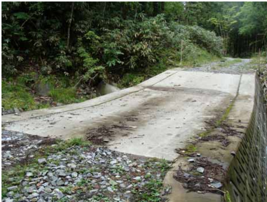
調査No20 暗渠付帯洗越工 排水施設安全率3.07 洗越安全率0.22 合算安全率3.29
