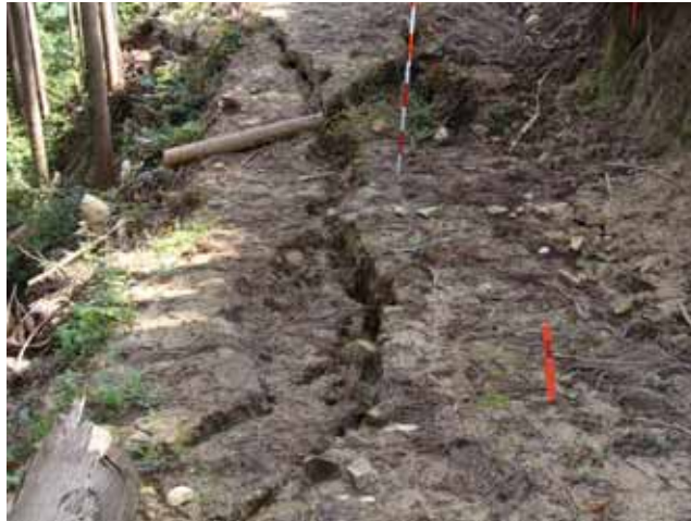
締固め不足による盛土の沈下
