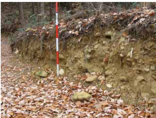
不均一さにより石礫が抜け落ちた切土のり面 (東京都多摩地区)
