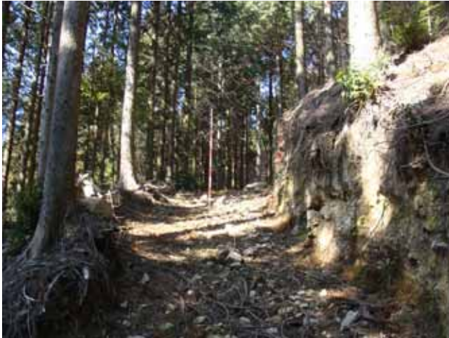
四万十累層の堆積岩質礫質土の切土のり面(宮崎県木城町)
