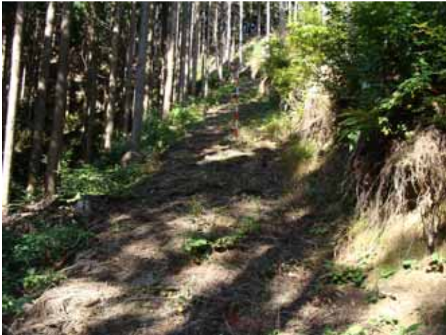
急勾配であるが侵食の発生していない路面(鳥取県日野町)
