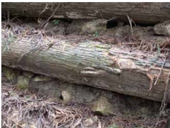
丸太組工前面に石礫を利用した一例(宮崎県木城町)
