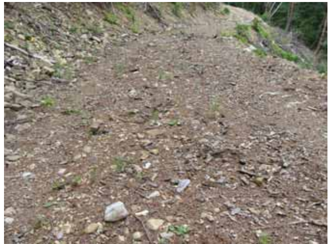
比較的締固められた盛土断面 (長野県伊那市)
