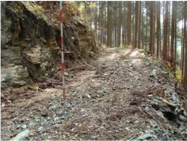
変成岩質礫質土(三波川変成岩帯)の切土のり面(愛媛県久万高原町)
