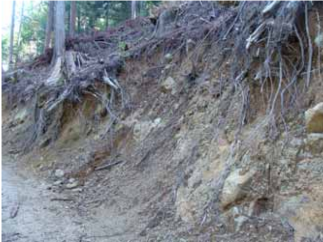
火成岩質礫質土(流紋岩)の切土のり面 (岐阜県東白川村)
