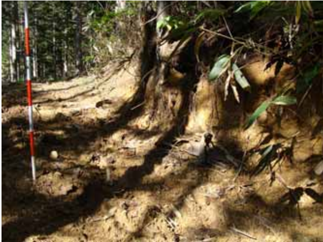
火山性堆積物の切土のり面
