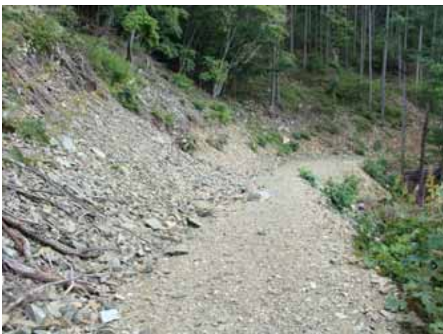
変成岩質礫質土の強度に変成を受けた切土のり面 (長野県伊那市)
