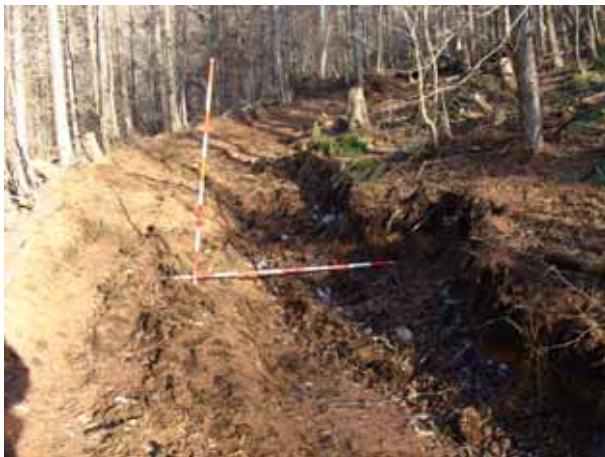
軟弱路盤走行による路盤の痛み(群馬県沼田市)
