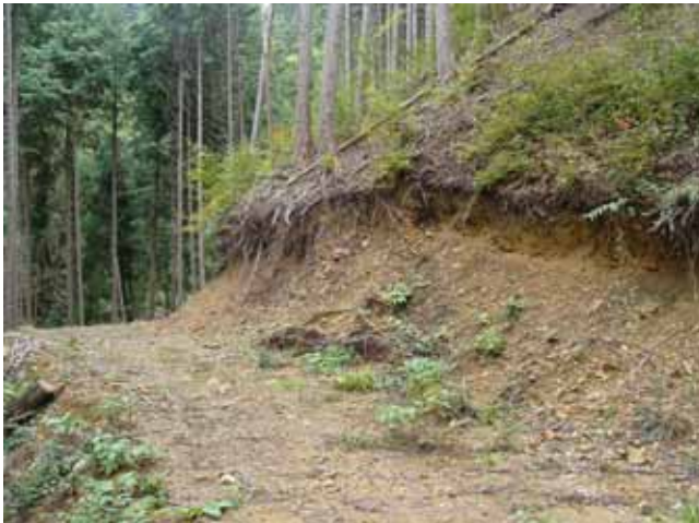
火山灰質礫質土(凝灰岩)を主体とした切土のり面(岡山県新見市)
