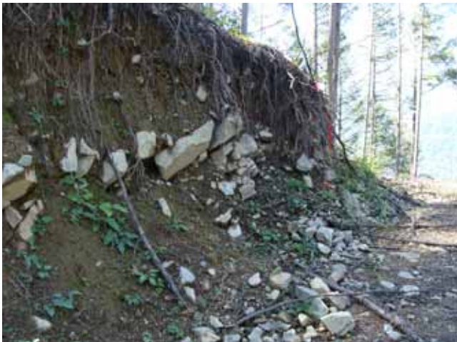
切土のり面に露出した沖積層の岩塊(長野県中信地方)
