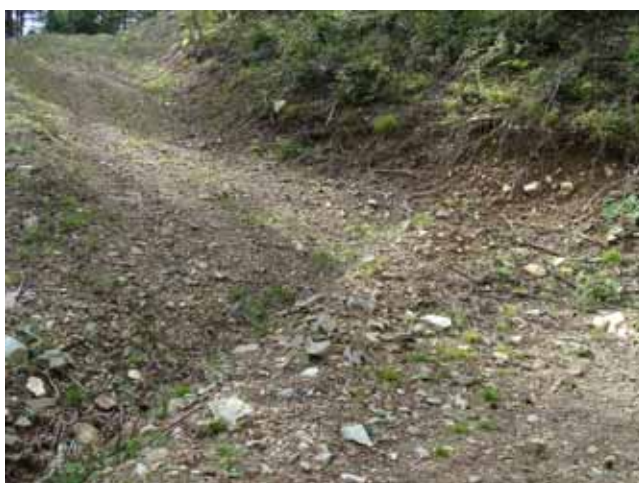
素掘りによる横断溝 長野県伊那市
