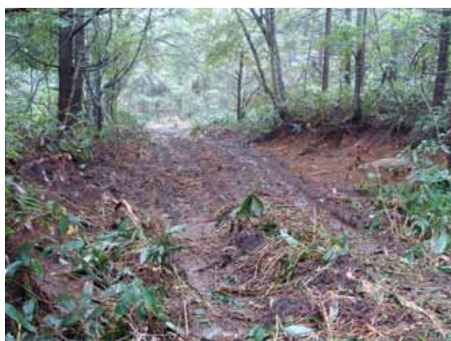
黒ボクが発達している箇所の路面の状況 (岩手県盛岡市)
