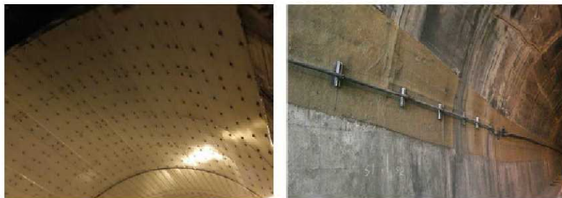
付写真-1.4.6 鋼板接着（左）・繊維シートの接着（右）例
