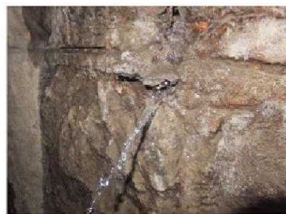
付写真-1.4.3 漏水（噴出）している例
