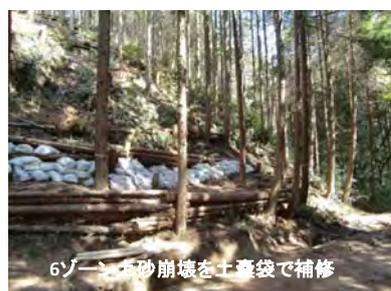
6ゾーン土砂崩壊を土嚢袋で補修
