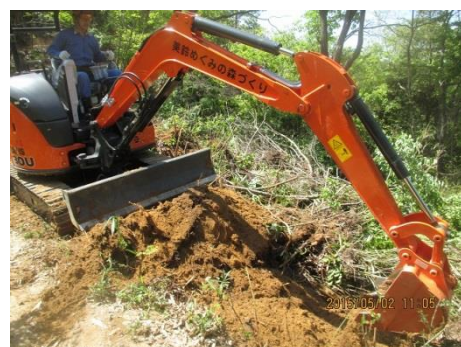
▲作業道と遊歩道を一体的に整備
