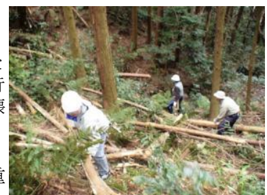
▲間伐と遊歩道づくりによる土留め
