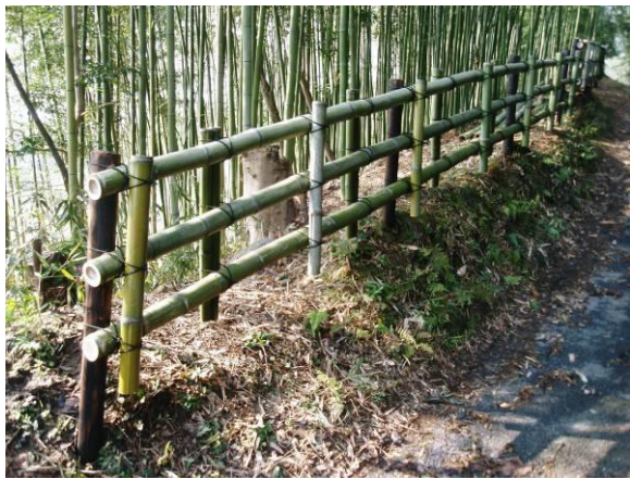
遊歩道の整理を行い、柵を設置
