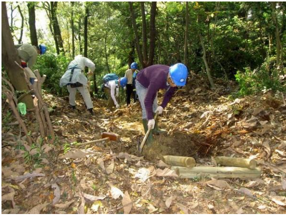
歩道整備・丸太階段設置
