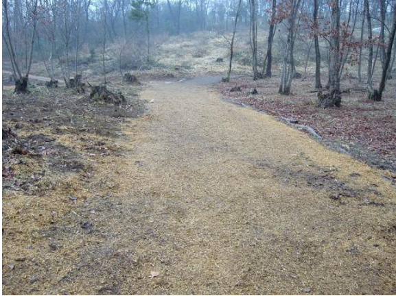
遊歩道整備 チップ材撒き
