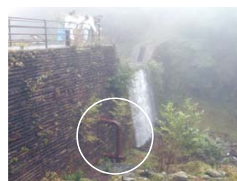
治山ダムと導水管
