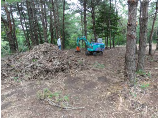
地掻きを行った林内
