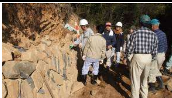
広葉樹の森の育て方教室。作業道法面に建設中の石垣を見学する。（22・12）
