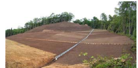
排土工工事状況(平成21年6月18日)
