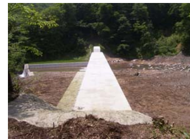
コンクリート谷止工 (平成21年7月15日)
