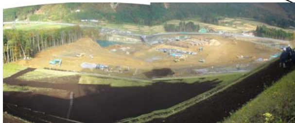
(市野々原) 全景(平成21年10月27日)
