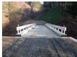
渋民3-2号、橋梁工2完成 (平成21年11月6日)
