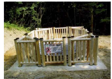
集水井完成状況(平成21年7月27日)
