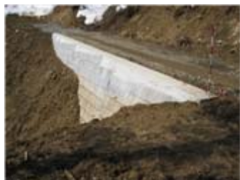
二段式擁壁完了
