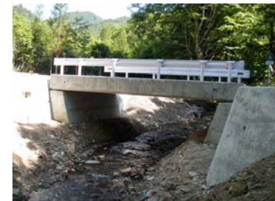
橋梁付替(平成21年6月25日)
