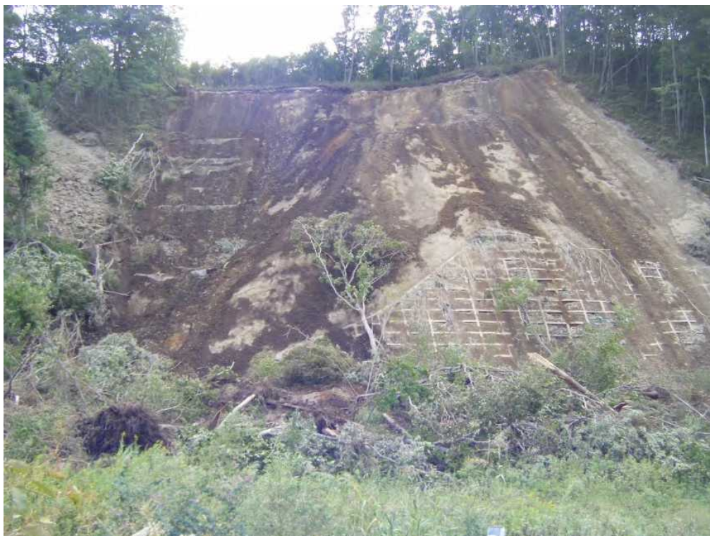
崩壊状況(平成9年に施工した法砕工の効果により被害は最小限にとどめている。)
