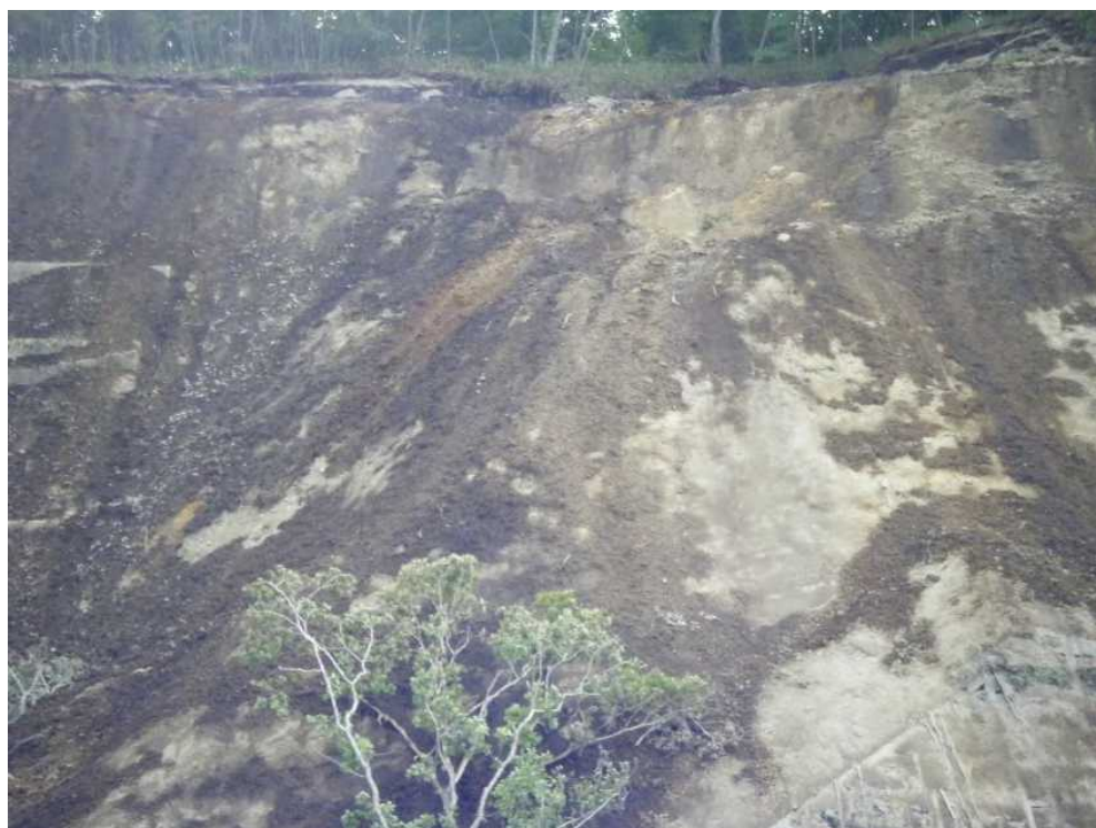
法砕上部の崩壊状況(急斜面であるため樹木(天然林)の生育は悪い)
