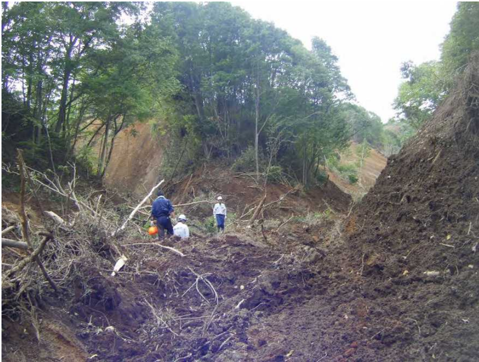
溪流内の崩積土、危険木の状況
