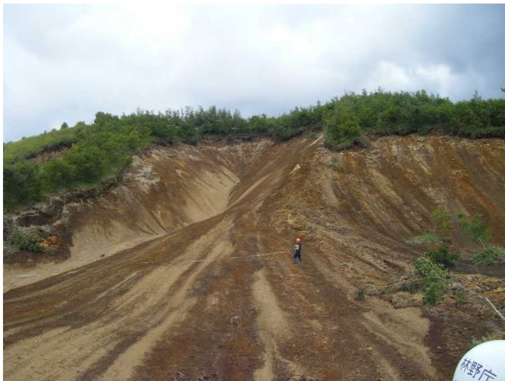
左側は谷地形、右側は平坦斜面での崩壊（白い部分がシルトで水分を含んでいる）
