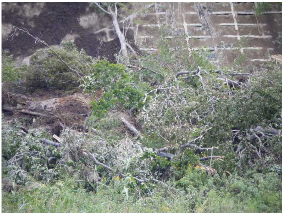
崩壊土砂は少なく、立木が堆積している状況（崩壊深さが浅い）
