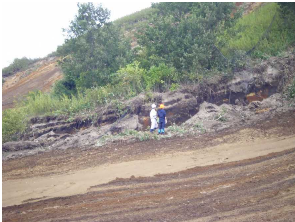
谷地形崩壊箇所の側崖(崩壊深は2m以上)
