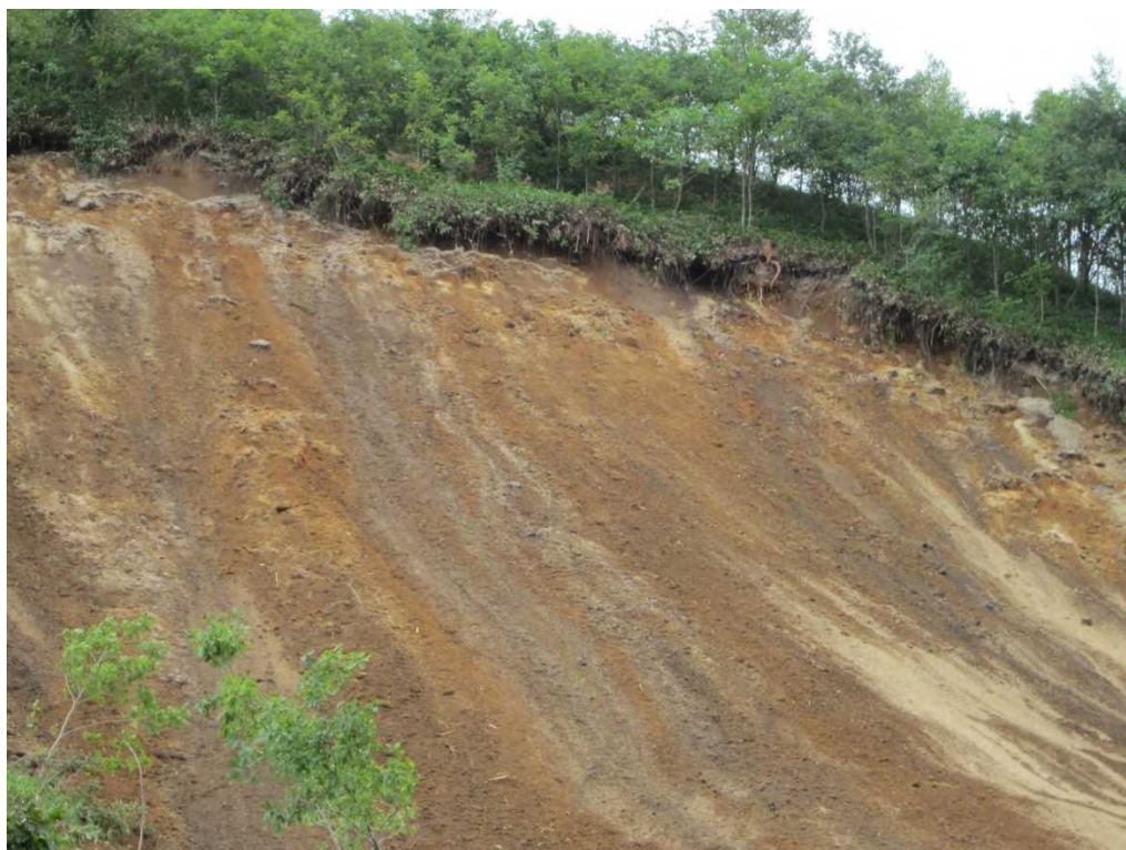
右側の平坦な地形での崩壊箇所（樹木の根より深い部分が滑り落ちている）
