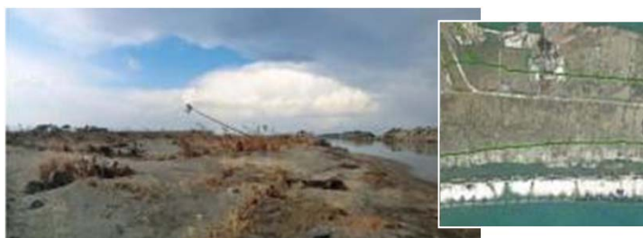
【福島県相馬市】基盤造成工事の入札公告中
