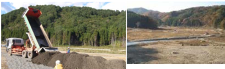
【岩手県宮古市】盛土材として再生資材を搬入
