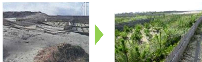
【茨城県神栖市】浸水被害箇所を再植林
