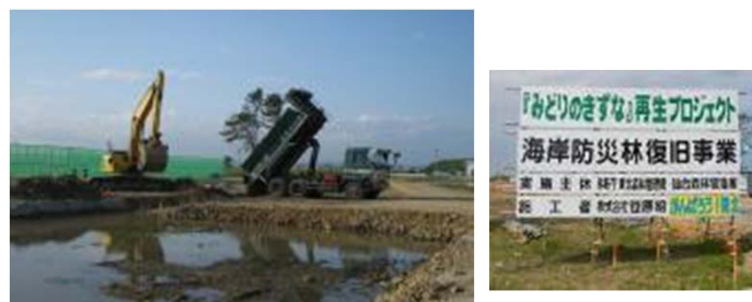
【宮城県仙台市】盛土材として再生資材を搬入
