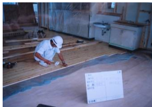
通常の施工 モルタル仕上げ面に下地合板を張り、床材を施工（玉川中学校）
