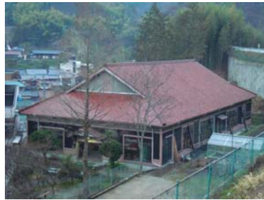
外観（足助小学校）
