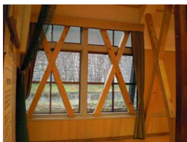
筋交いによる壁補強（足助小学校）
