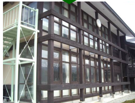
土淵中学校 校舎外観 (上) 塗装前、(下) 塗装後
