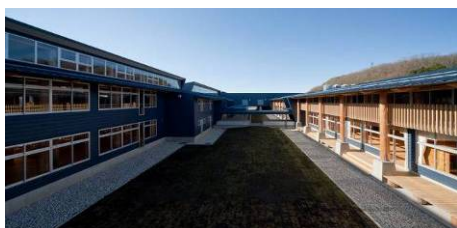
普通教室棟北面と特別教室棟北面の外観
