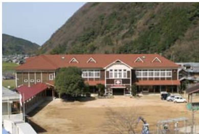
東側外観：県内産のスギ板の下見板張りの外壁
