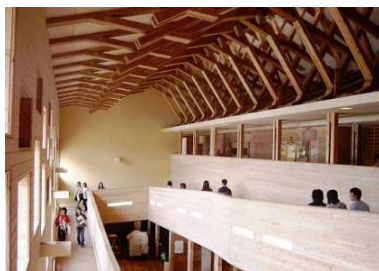
接着重ね梁が使用されたスロープ部
