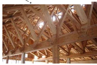
体育館小屋組
