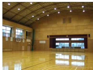
体育館 (天井の高い部分は合板を使用)
