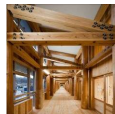
内部の木材継手状況
