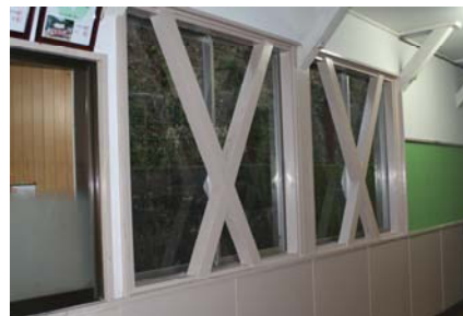
筋交いによる壁補強（追分小学校）
