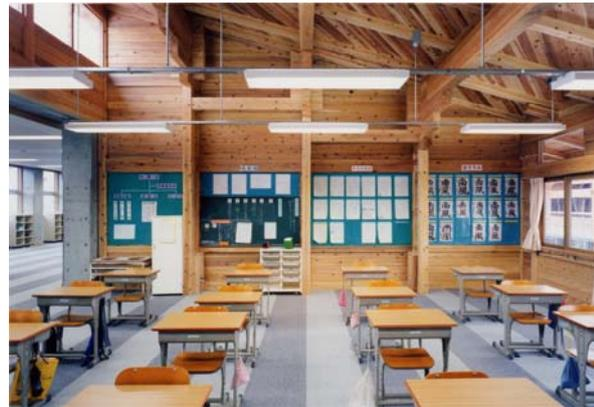
落とし込み板の耐力壁と屋根面の斜め板張り
