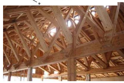
体育館小屋組
