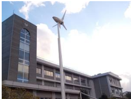
校舎北側・外断熱（スギ）
