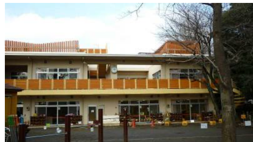
間伐材を使用したバルコニー手すり
