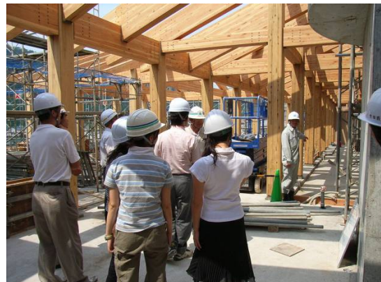
建方中の現場の見学会
