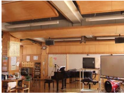
・音楽室の木質化状況
