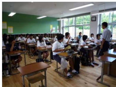
教室、廊下の床、腰壁(クロマツ)
