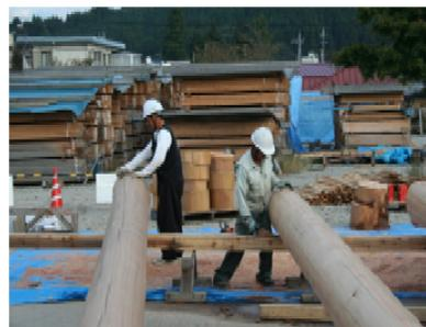
地元大工による丸太材の加工
