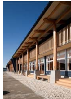
普通教室棟南面の軒先
