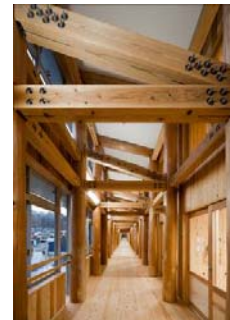
内部の木材継手状況
