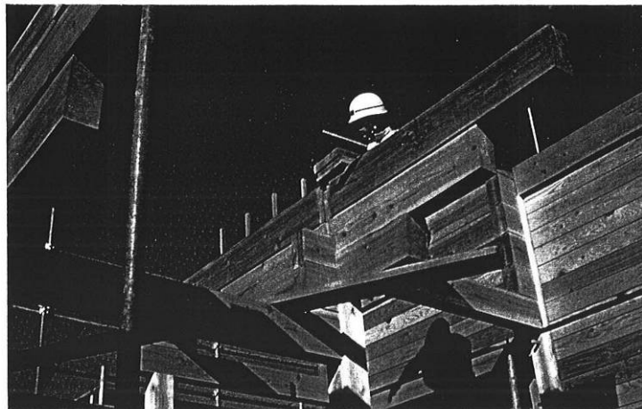
持送り重ね梁建方
