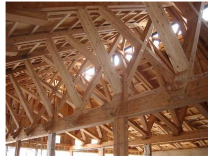
体育館小屋組
