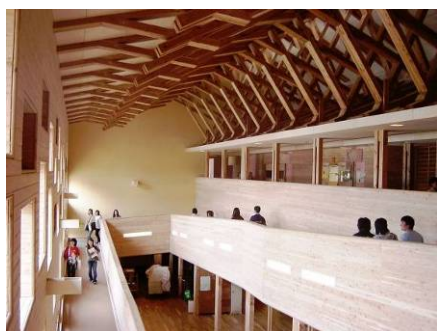
接着重ね梁が使用されたスロープ部
