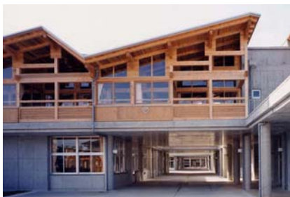
つくば市立東小学校 校舎外観
