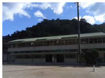
日土小学校 既存校舎棟
