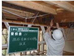
写真 2 既存金物ボルト締め
