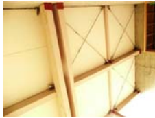
写真 6 図書室下ブレース補強
