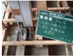
写真 4 ブレース脚元金物溶接止め
