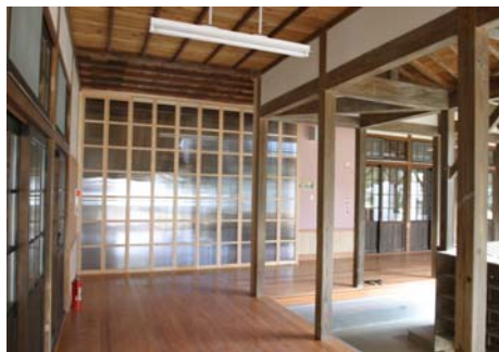
開放廊下の冬季対策としての、開放階段室前の可動間仕切
