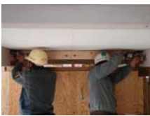
写真 5 図書室下床ブレース入れ替え
