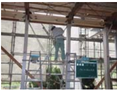
写真 3 改修壁ブレース締め
