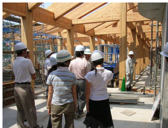
建方中の現場を見学会
