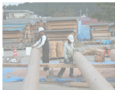
地元大工による丸太材の加工
