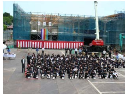
生徒全員参加による上棟式
