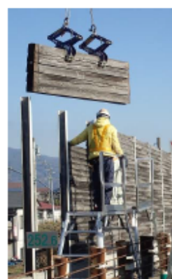
写真-1 遮音板交換 (2015. 12. 7)
