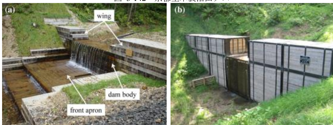
図 3-143 秋田型木製治山ダム(a)オールウッドダム、(b)ハイブリットダム (Noda et al., 2014)
