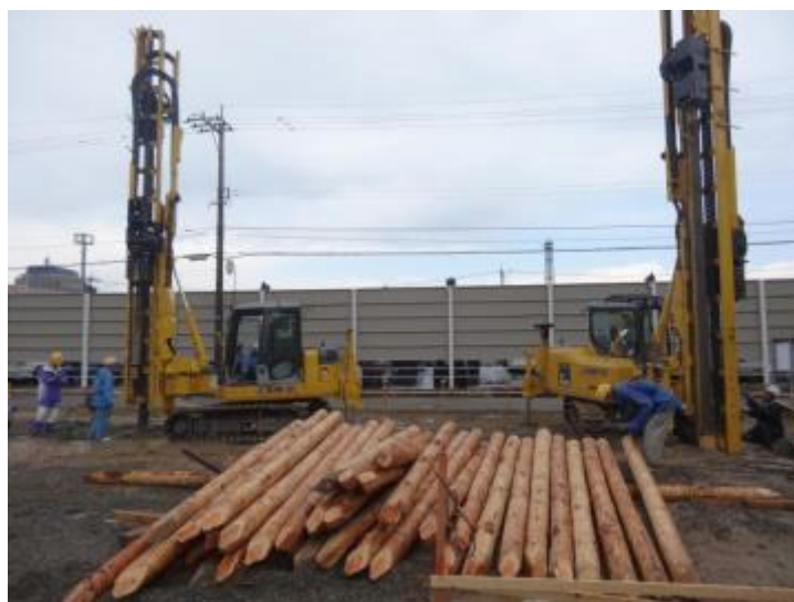
図 3-128 飛鳥建設による丸太打設工事の様子（金沢市、平成 26 年 11 月撮影）
