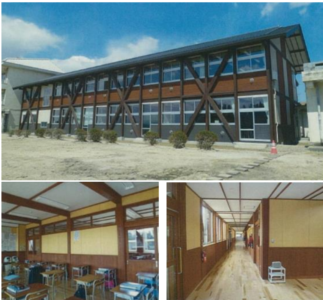
図 3-73 木造校舎内外観
