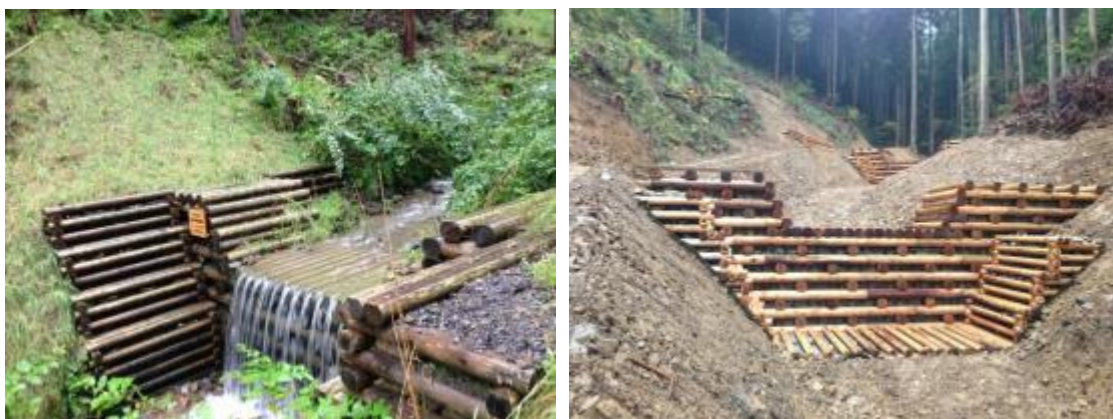
図 3-142 京都型木製治山ダム
