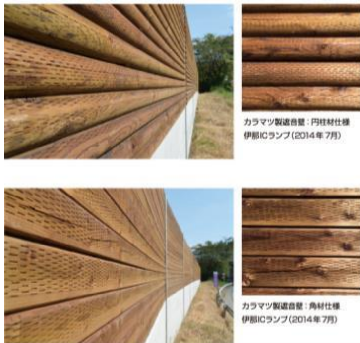
図 3-136 長野県における木製遮音壁の外観（上：円柱仕様、下：角材仕様） 出典：土木学会「シンポジウム：これからの遮音壁を考える」2014 年 10 月
