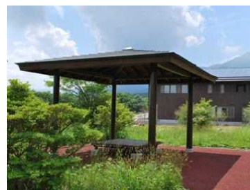
那須高原ビジターセンター四阿 H23（栃木県 那須町）
