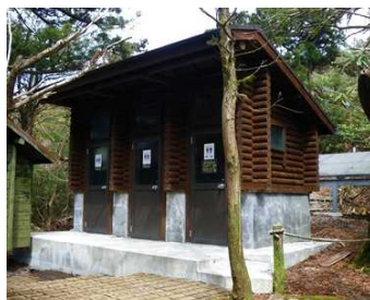
宮之浦岳縄文杉線歩道トイレ H23（鹿児島県 屋久島町）
