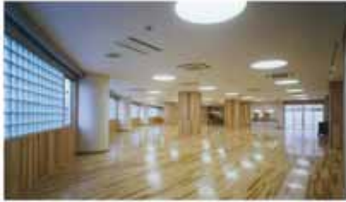
東京都 杉並区立松溪中学校 (RC造一部鉄骨造 内装木質化)
