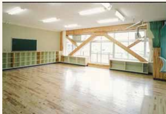
耐震化を行うとともに、内装木質化を図り、 耐震プレスの圧迫感を低減した事例 (兵庫県朝来市立枚田小学校)
