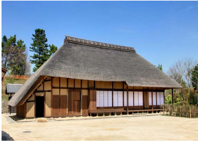
国営昭和記念公園 こもれびの里 主屋 (東京都立川市、1階建て、169 m 2 )
