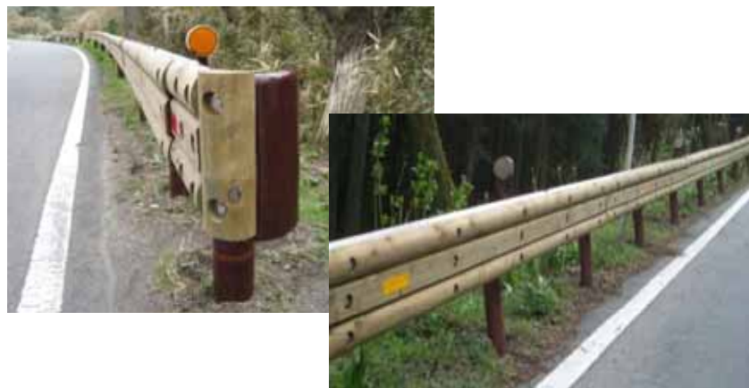
C. 既存の鋼製ガードレールに固定、スギ(製材加工)
