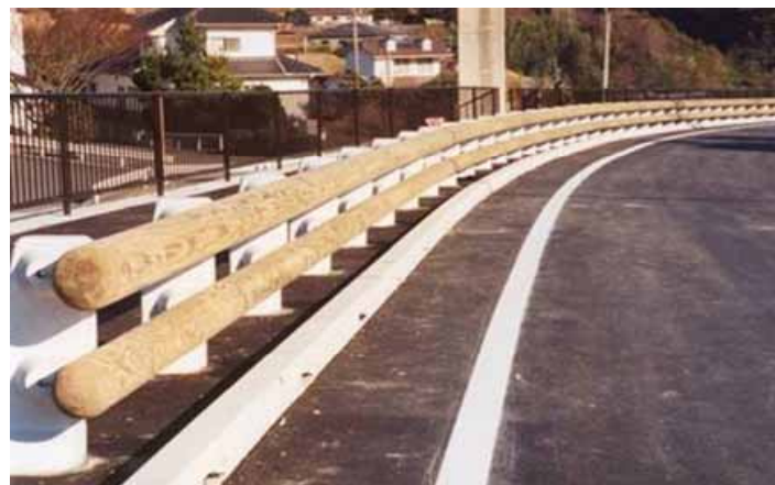
B. コンクリート支柱、スギ(円柱加工)
