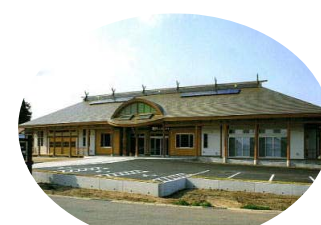
木造公共施設
