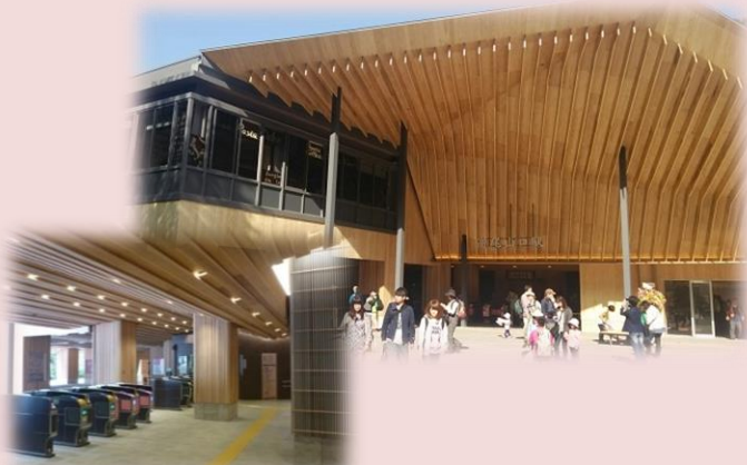
京王電鉄高尾山口駅（内外装木質化） （東京都八王子市）
