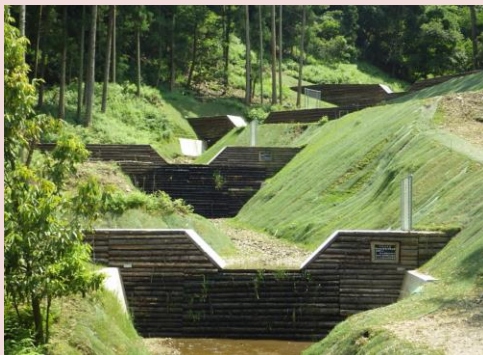
丸太式残存型枠工（広島県竹原市）
