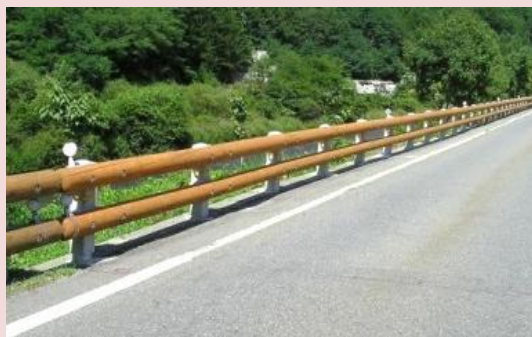
木製ガードレール
