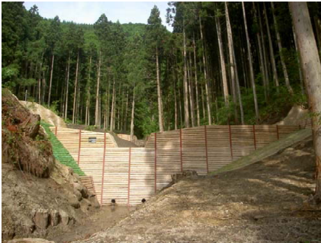
治山工事の残存型枠（福島県郡山市）
