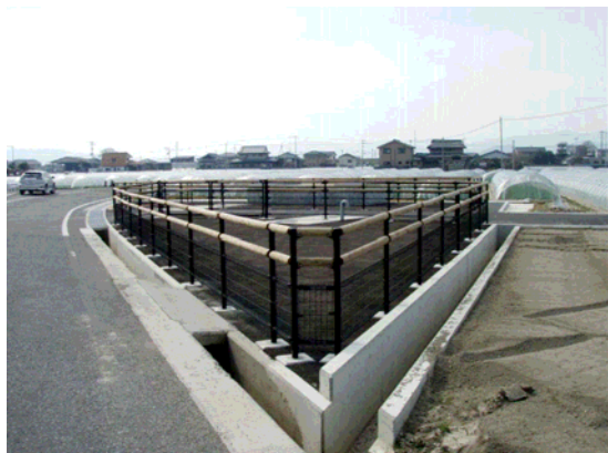
防護柵（徳島県板野町）
