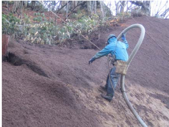
チップの植生基材吹付工
