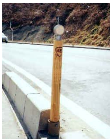
視線誘導標の例
