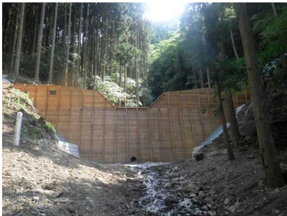
残存型枠工 (熊本県八代市) [予防治山事業]
