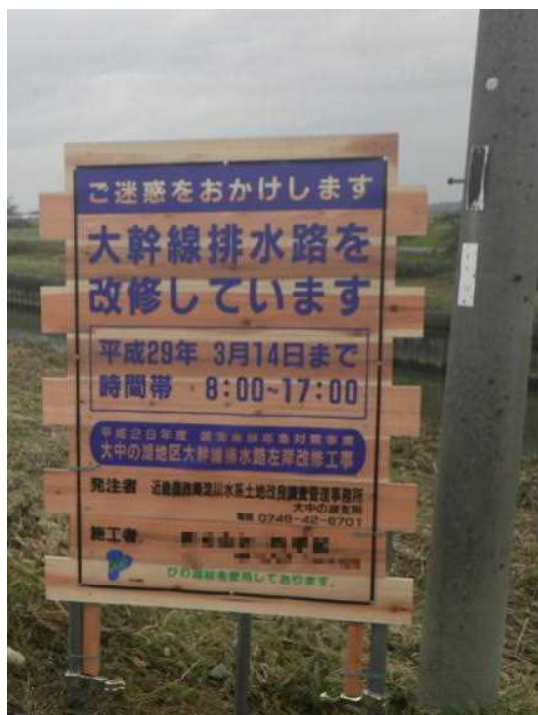
工事用看板 (滋賀県東近江市大中町) [国営施設応急対策事業]
