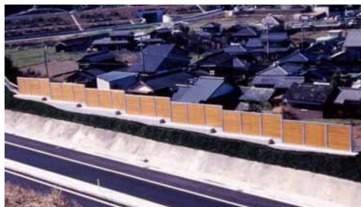
D. 木製遮音壁
