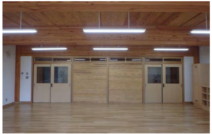
内観 教室（構造材顕し・内装木質化）
