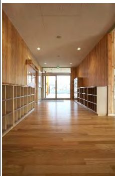
◀CLTパネルを現し仕上げとした内装
