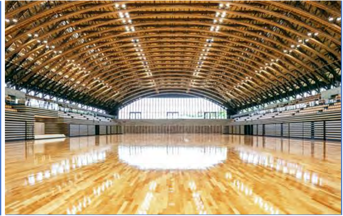
内観 多目的競技場（一部木造＋内装木質化）
