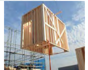
個室ユニットの施工状況
