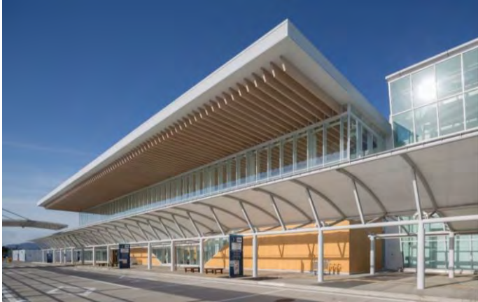
外観 西側増築部
