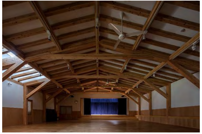
内観 遊戯室（内装木質化）
