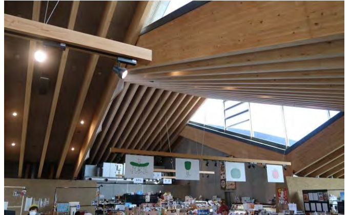
内観 ホール(大断面集成梁)
