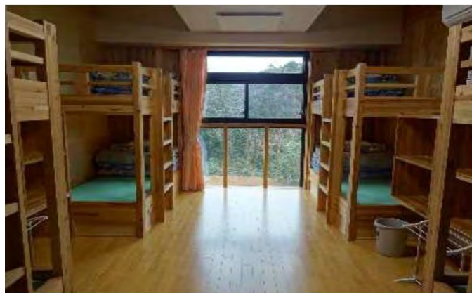
内観 宿泊室（CLT耐震壁）
