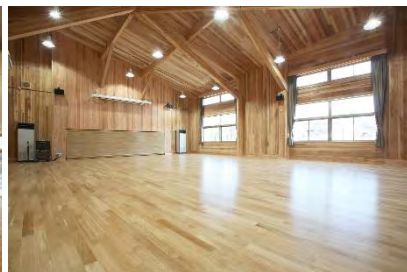
▲CLTパネル工法による大遊戯室
