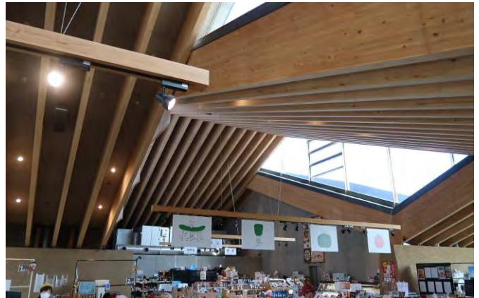
内観 ホール(大断面集成梁)
