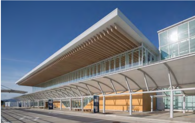
外観 西側増築部
