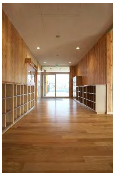
◀CLTパネルを現し仕上げとした内装
