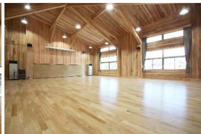
▲CLTパネル工法による大遊戯室
